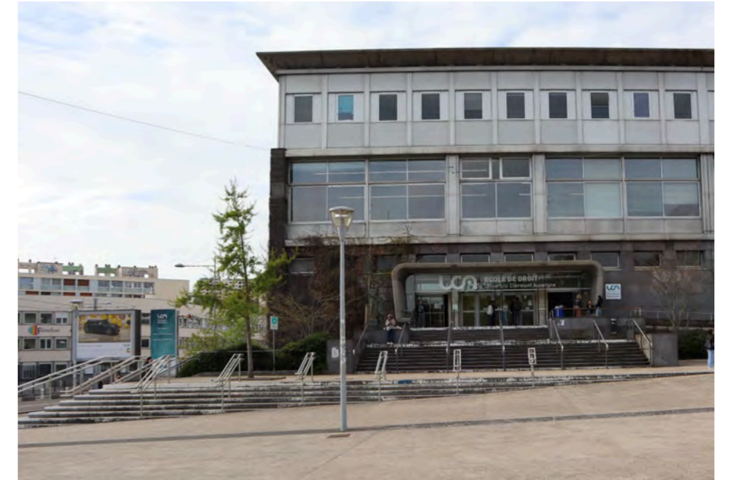
Repérage : photographie de l'élévation nord
